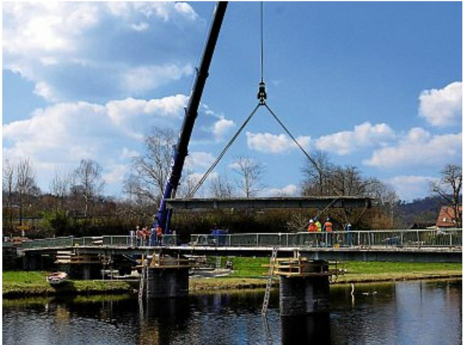
**Die Arbeiten für die Erneuerung der Schillerbrücke schreiten voran.** Vergangene Woche wurde mittels Autokran der Brückenüberbau abgehoben und mit zwei Tiefladern abtransportiert. In den nächsten Wochen finden vorbereitende Maßnahmen an den Pfeilern und Widerlagern statt, so dass voraussichtlich ab Di., 26. Apr., die neue Brückenkonstruktion eingeschwenkt werden kann.
