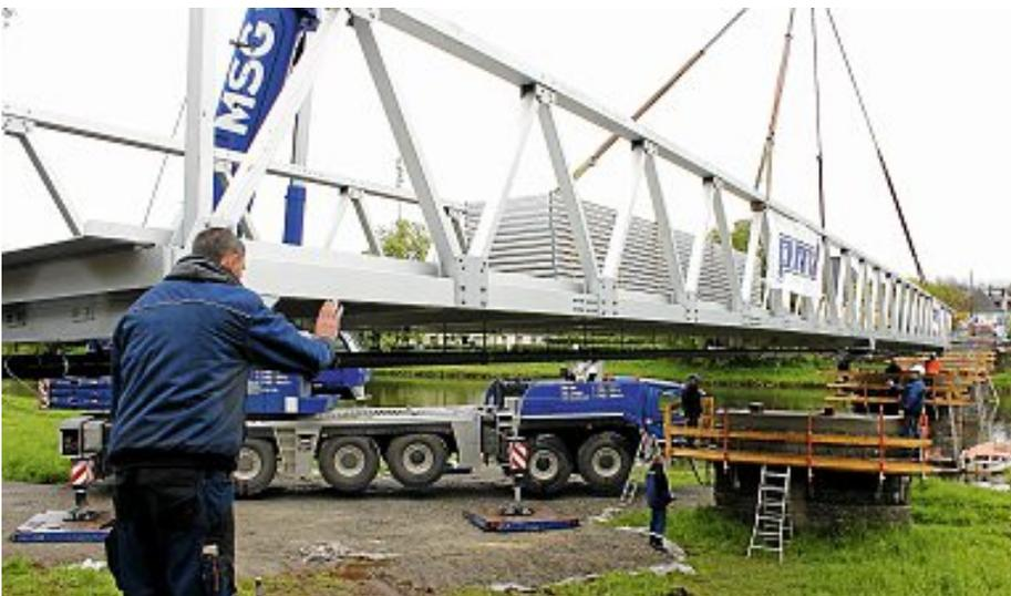
**Die neue Schillerbrücke ist eine Fuß- und Radwegbrücke aus Aluminium.** Über eine Länge von 86 Metern erstreckt sie sich mit einer Durchgangsbreite von drei Metern über die Murg. In dieser Woche wurde das mehrteilige Bauwerk montiert. Mit einem Gewicht von rund 20 Tonnen ist die Brücke ungleich leichter als ihr Vorgängermodell aus Stahlbeton. Bevor sie wieder geöffnet werden kann, müssen im Monat Mai noch Restarbeiten durchgeführt werden. Foto: StVw
