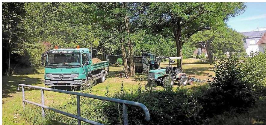
In Ottenau sind diese Woche die Sanierungsarbeiten für den Bolzplatz am Bahnbach gestartet. Der sehr unebene und steinige Platz wurde abgeschleppt und eingeebnet. Im Anschluss erfolgt eine neue Rasenansaat. Die Stadtverwaltung bittet um Verständnis, dass der Platz jetzt bis zum Auflaufen der Gräser gesperrt bleiben muss. Als Ausweichstelle kann der Bolzplatz neben dem Kinderspielplatz in der Josef-Vogt Straße genutzt werden.
