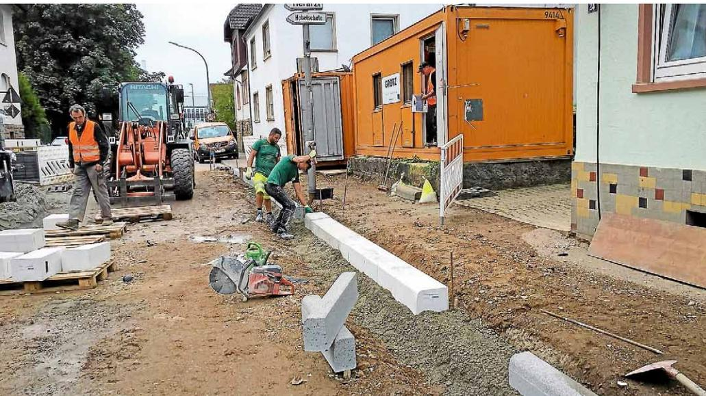
Arbeiter setzen die Bordsteine - der erste Bauabschnitt ist damit bald abgeschlossen.
