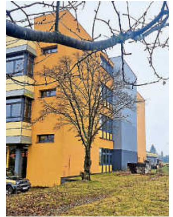
Mit dem Anbau an die Realschule soll in etwa einem Jahr begonnen werden.
