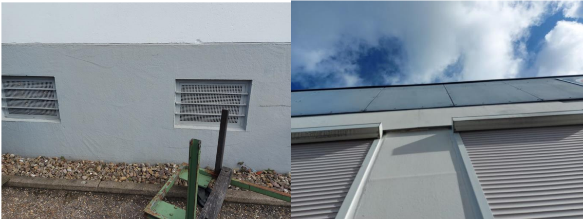
Abbildung 2 Verschlossene Kellerfenster und Dachbereich am zurückzubauenden Gebäude
