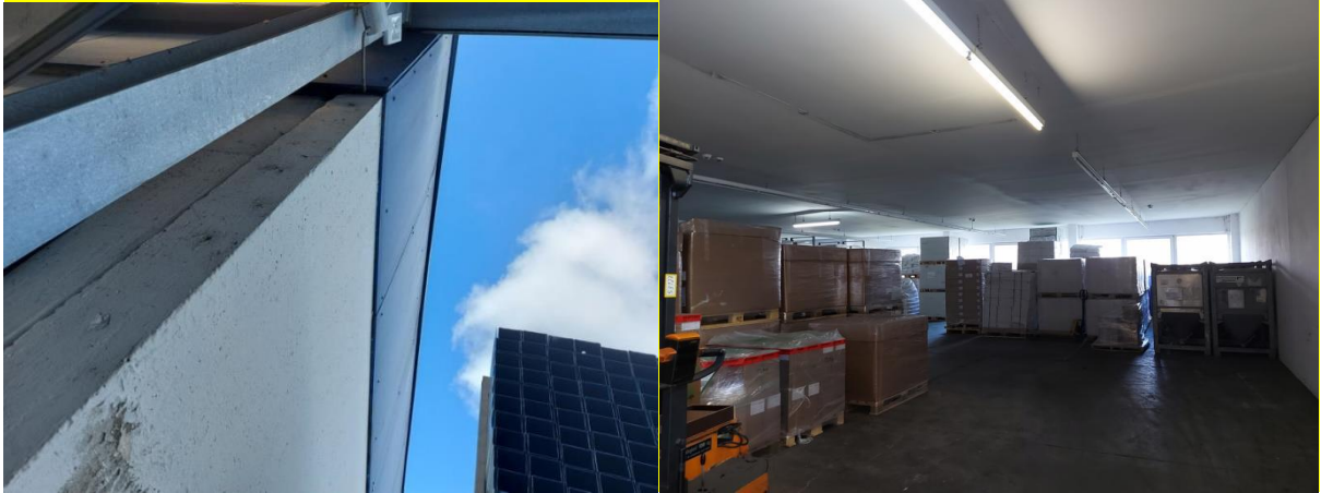
Abbildung 5 Dach- und Innenbereich des zurückzubauenden Gebäudes
