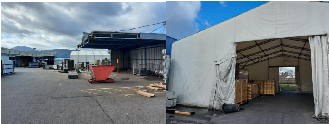
Abbildung 4 Bereich des Flughallendachs (Blick nach Südwesten) und Zelt
