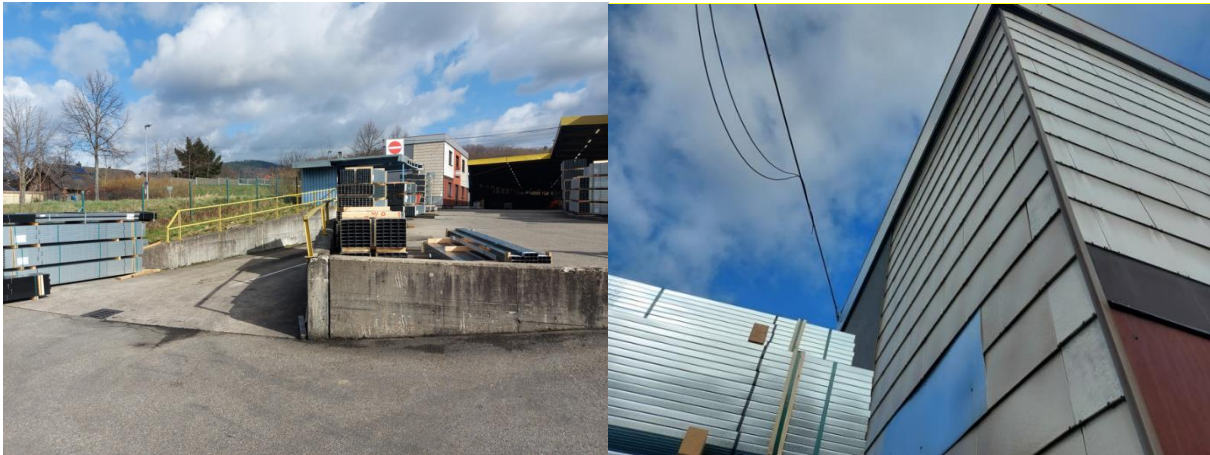
Abbildung 3 Bereich für Flughallendach mit geschlossenem Dach und Schindeln am nördlich gelegenen Gebäude
