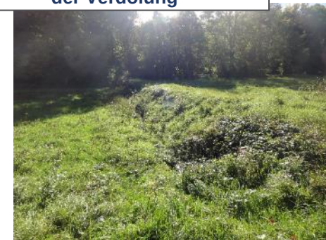
Querdamm und Einlauf der Verdolung
