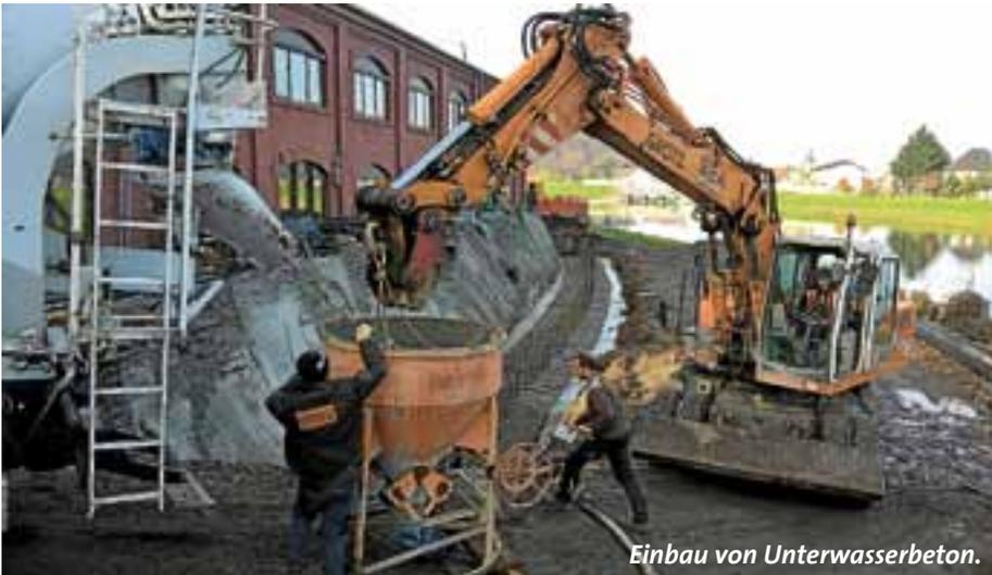
Einbau von Unterwasserbeton.
