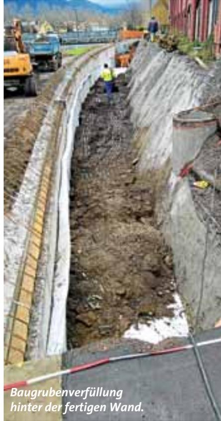
Baugrubenverfüllung hinter der fertigen Wand.
