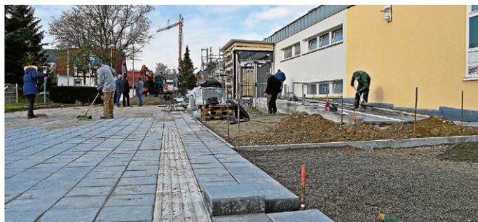
Behindertenparkplätze, Rampe und taktiles Bodenleitsystem sind zur Verbesserung der Barrierefreiheit gebaut worden.
