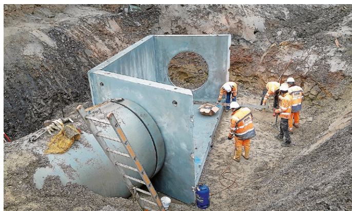
Schwere Maßnahme gegen Wasserfluten.
