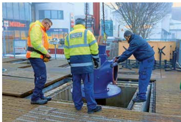
Die generalüberholte Pumpe wurde wieder eingebaut.
