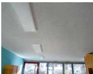
Neue Schallschutzdecke im Kindergarten St. Antonius. Foto: Kiga
