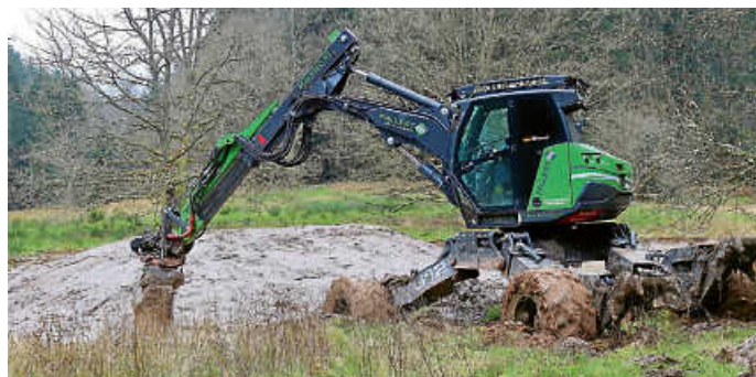
Mithilfe eines Schreitbaggers wurden die Kleingewässer gegraben.
