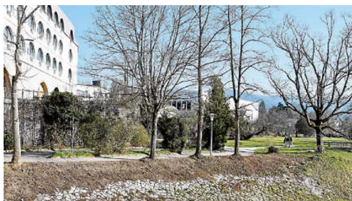
Murgpark und Haus der Inklusion gehören zum Sanierungsgebiet.
