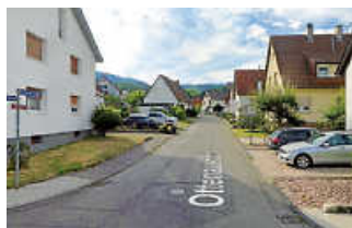
Vollsperrung wegen Arbeiten für einen Hausanschluss.
