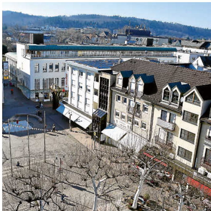
Der südliche Teil der Innenstadt soll Sanierungsgebiet werden.
