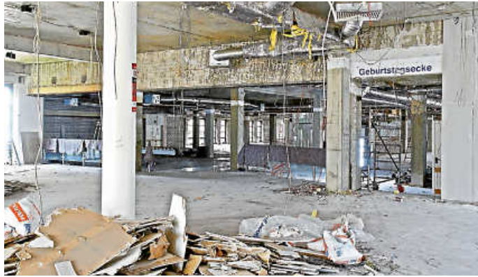
Das Gebäude wird komplett entkernt.
