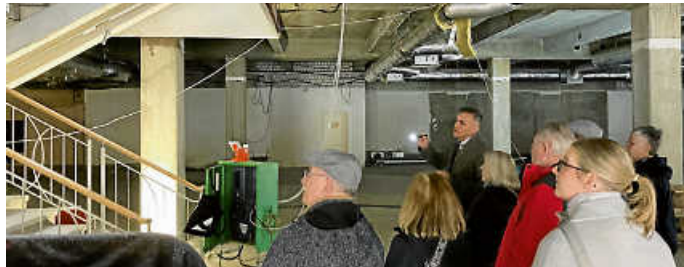
Führungen durch die Baustelle.
