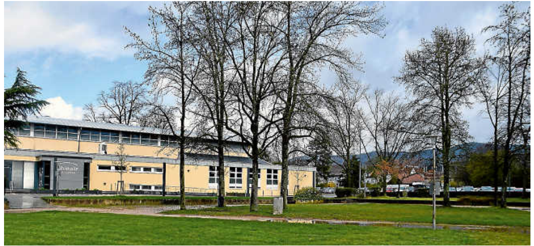
Hier soll das neue klag gebaut werden.
