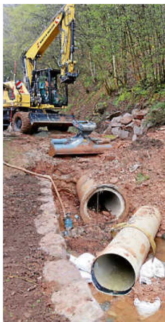
Die jetzige Verdolung wird zurückgebaut.
