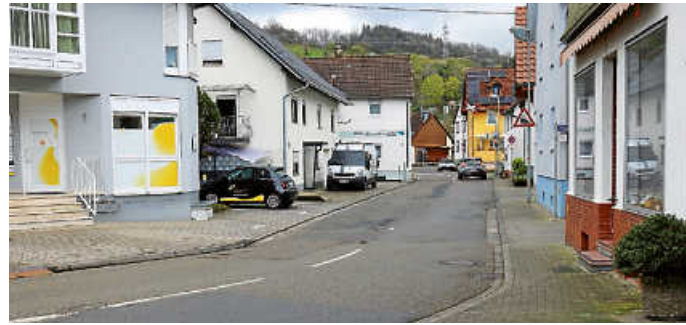
In der Hördener Straße wird der Kanal saniert.
