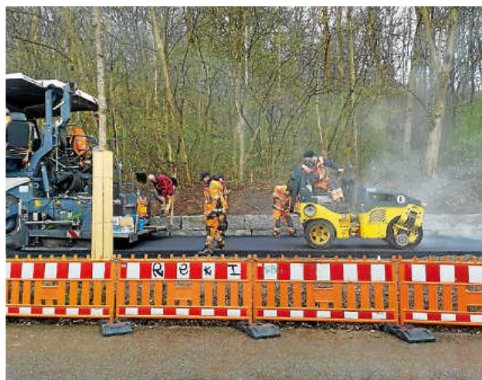
Die Walze rollt über das Bitumen.
