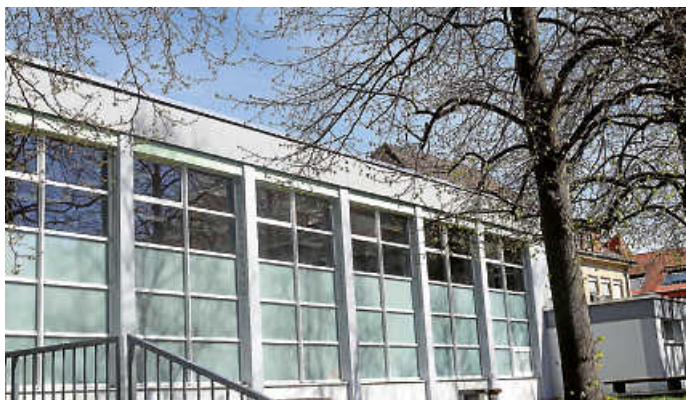
Die Sporthalle der Hans-Thoma-Schule wird saniert.
