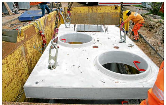
Maßarbeit: Die Platte verschließt den Drosselschacht. Als Nächstes wird die Baugrube verfüllt. Foto: Stadt Gaggenau
