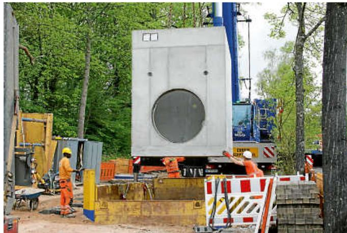
Das 32-Tonnen schwere Sonderbauteil wird mithilfe eines Krans in die Baugrube gelassen. Foto: Stadt Gaggenau
