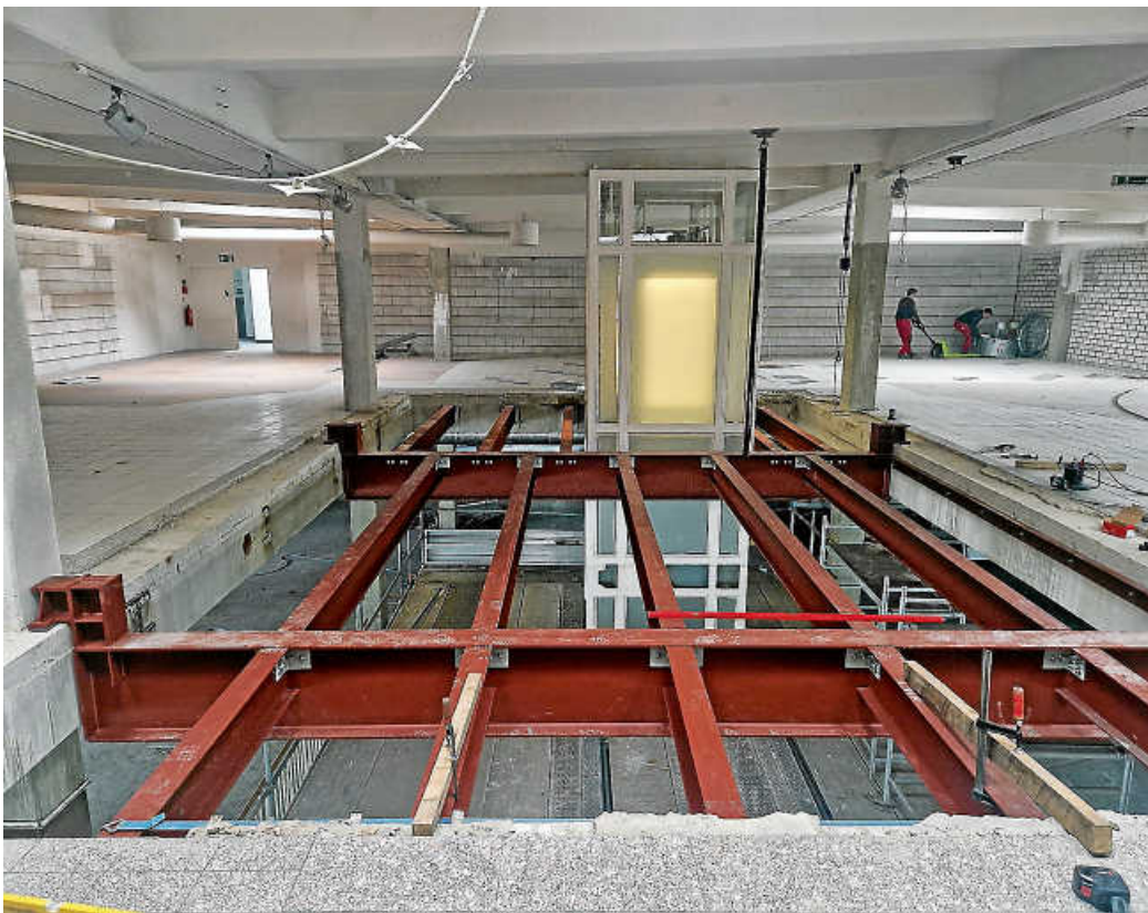
700 Kilogramm schwere Stahlträger wurden für die neue Decke zwischen 1. und 2. Obergeschoss eingebaut.
