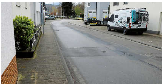
In diesem Bereich stehen Kanalsanierungen an.
