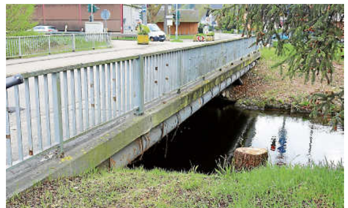
Die Brücke über den Floßkanal wird im Sommer saniert.
