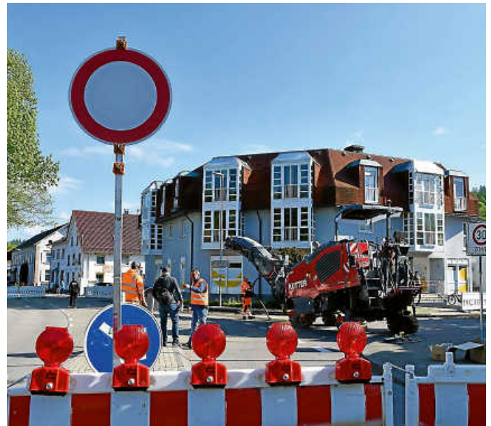
Die Baustelle im Kreuzungsbereich hat begonnen.
