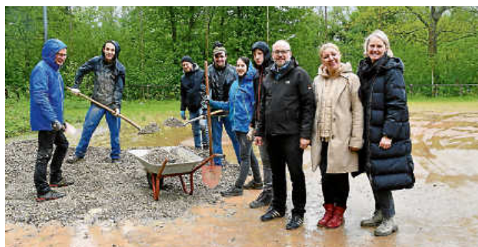
Bürgermeister Paul besucht die Mitwirkenden. Diese arbeiteten trotz des Regens beharrlich weiter. Foto: Stadt Gaggenau
