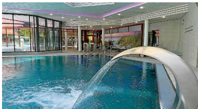
Wellness- und Bewegungsbecken: Die Instandsetzungsarbeiten sind abgeschlossen. Fotos: Rotherma
