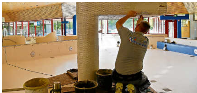
Nach den Instandhaltungsarbeiten hat das Rotherma jetzt wieder geöffnet. Foto: Stadt Gaggenau
