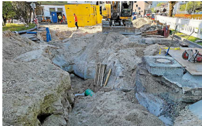
An der Kreuzung Landstraße / Hördener Straße gibt es derzeit eine große Baustelle. Foto: Stadt Gaggenau
