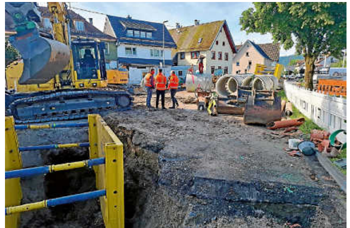
Die Baumaßnahme gegenüber der Flößerhalle läuft.
