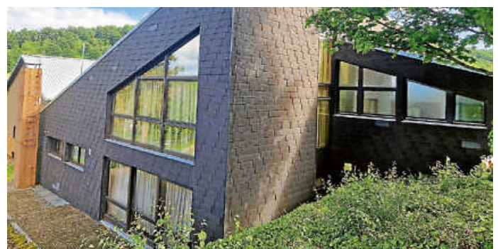
Das Sulzbacher Vereinsheim soll umfassend saniert werden.
