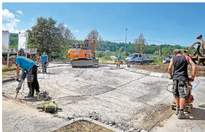
Abtragen der verbrannten Fahrbahndecke im Kreisverkehr.
