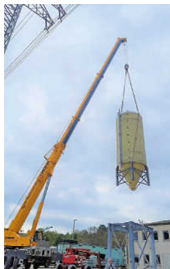
Hängt in der Luft: Das alte Salz-silo. Foto: Stadt Gaggenau
