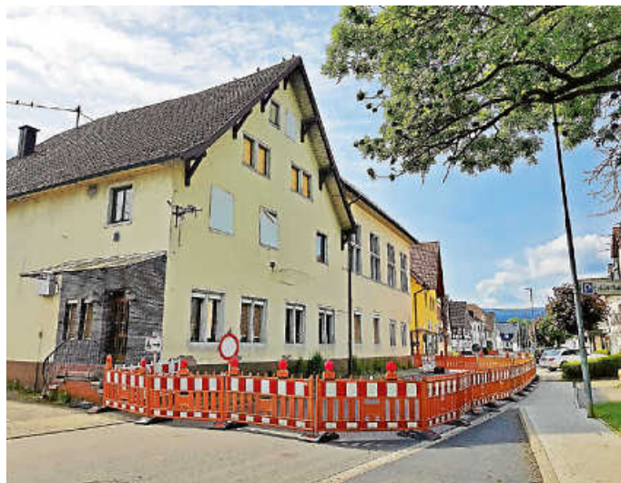
Wegen Einsturzgefahr muss die Straße weiter gesperrt bleiben. Foto: StVw
