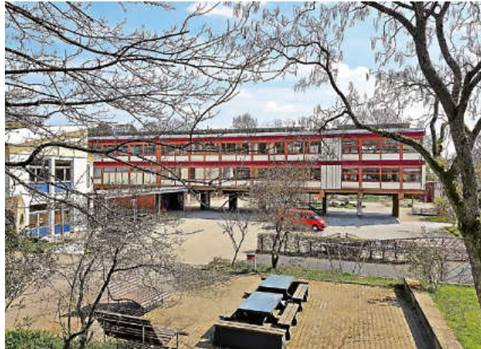
Das Goethe-Gymnasium ist einer der größten Energieverbraucher und wird sukzessive saniert. Foto: StVw
