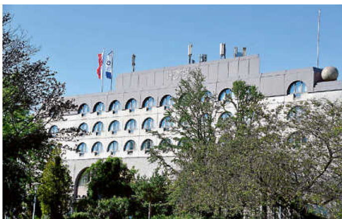
Dahinden ließ die Formen sprechen: die Fassade des Parkhotels mit ihren einzigartigen Fenstern. Foto: Stadt Gaggenau
