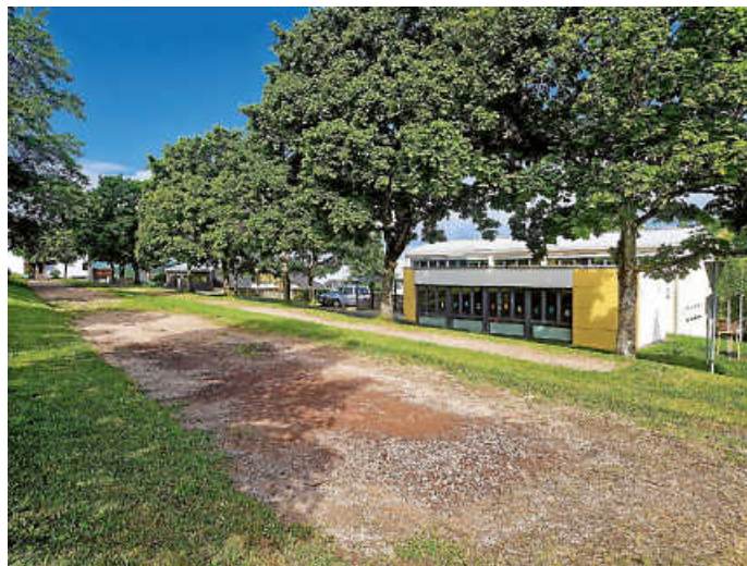
Im Bereich „Im Äckerle“ soll der neue Kindergarten entstehen.
