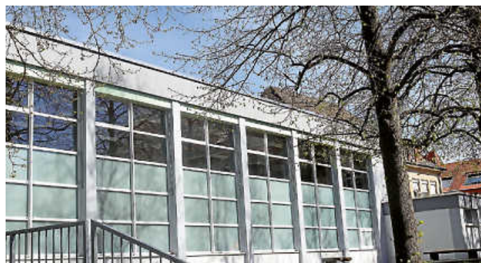
Das Hallendach wird saniert.
