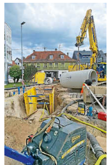
Größere Betonrohre werden eingebaut. Fotos: Stadt Gaggenau
