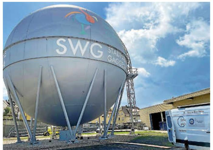
Aufwendige Prüfung, insgesamt 33 Sensoren überwachen die Gaskugel bei der TÜV-Prüfung. Foto: Stadtwerke
