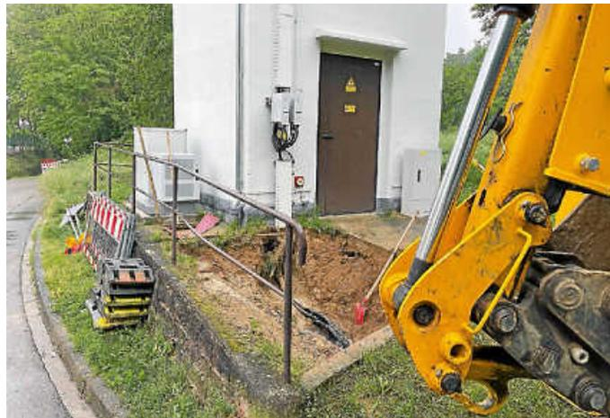
Reparaturarbeiten an der defekten Mittelspannungsleitung in Oberweier. Foto: Stadtwerke
