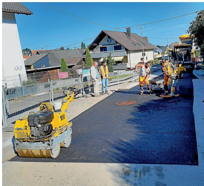
Die Kanalbauarbeiten in Oberweier sind abgeschlossen. Foto: StVw
