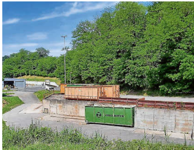
Während der Bauarbeiten am Hallendach wird die ehemalige Kleinanliefererrampe reaktiviert und zur Annahme von Sperrmüll, Altholz und Metall genutzt. Foto: AWB/Denis Machein
