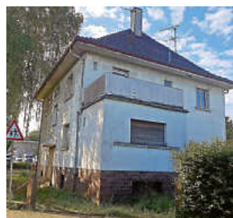
Das Gebäude soll abgerissen und durch einen Neubau ersetzt werden. Foto: StVw
