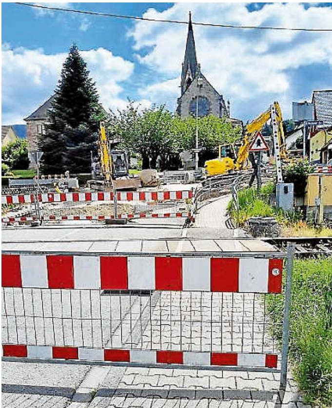
Fußgänger müssen bis nächste Woche über die Brunnenwiesenstraße ausweichen. Foto: Stadt Gaggenau
