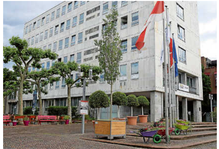
Neuer Pflanzkübel mit einer besseren Versorgungstechnik.
