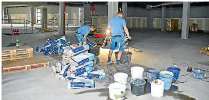
Auf Hochtouren wird im ehemaligen City Kaufhaus gearbeitet.
