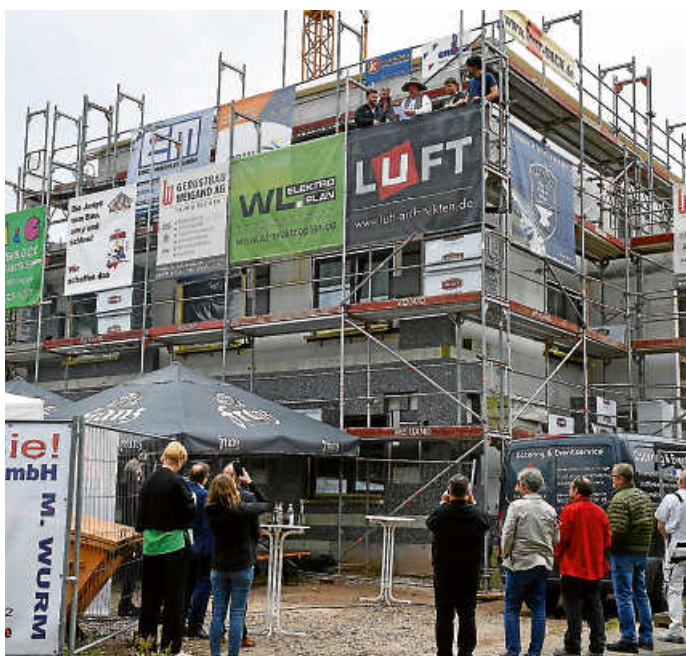
Richtfest: Der Rohbau an der Eckenerstraße steht. Foto: Stadt Gaggenau
