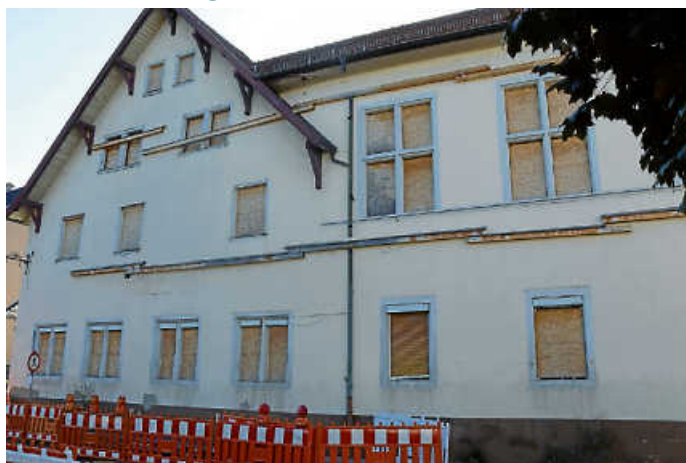
Die Vollsperrung ist beendet - es wird nur noch halbseitig gesperrt. Foto: Stadt Gaggenau
