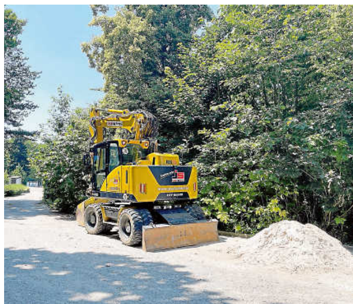
Die ersten Bagger rollen für den Glasfaserausbau.
