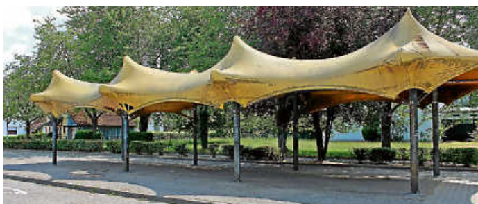
Bis zum Herbst soll die neugestaltete Bushaltestelle fertig sein.
