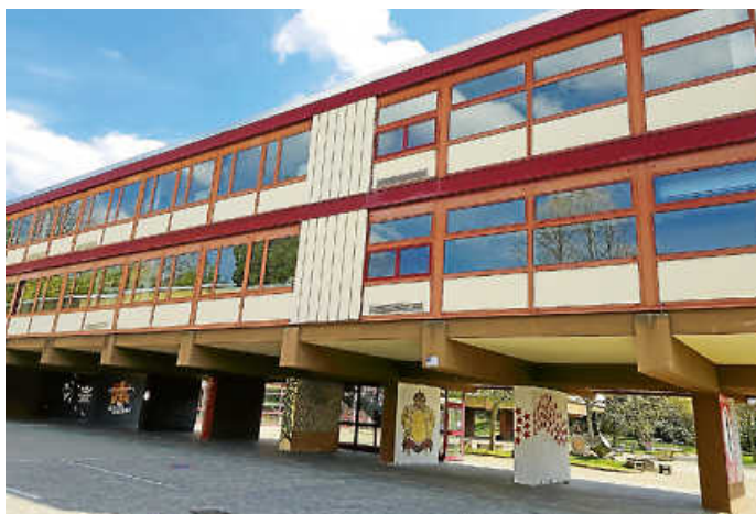
Das Goethe-Gymnasium soll sukzessive energetisch saniert werden.
