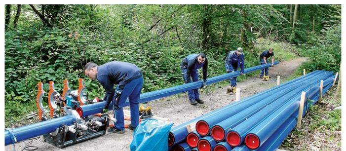
Mitarbeiter der Stadtwerke legen ein neues Rohrsegment in die Spiegelschweißanlage im Wald zwischen Oberweier und Winkel.
