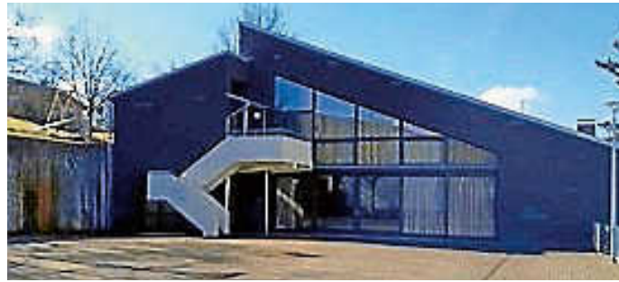
Umfassend saniert werden soll das Sulzbacher Vereinsheim.
