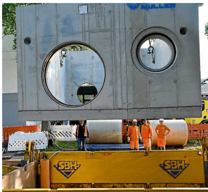
45 Tonnen wiegt das Sonderbauteil.
