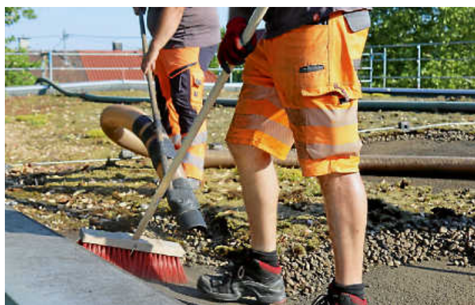
Der Kies wird vom Dach der Sporthalle gesaugt.
