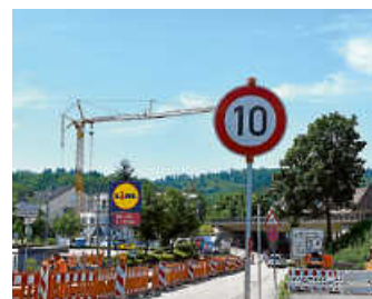
Die Geschwindigkeit an der Baustelle wurde reduziert.
