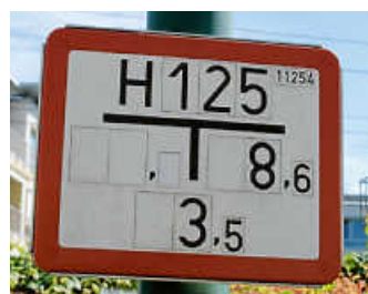
Dieses Schild zeigt, wie weit der Hydrant entfernt ist.
