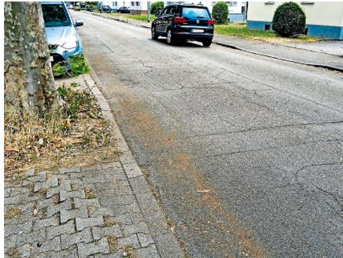
Die Schulstraße wird bald saniert werden. Foto: Stadt Gaggenau
