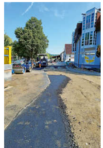
Die Landstraße wird asphaltiert.
