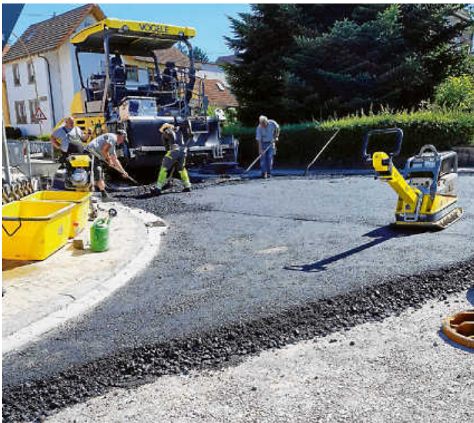
Die Arbeiten am Bahnübergang sind diese Woche abgeschlossen. Foto: Stadt Gaggenau
