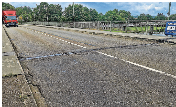
Für Oktober sind Bauarbeiten an der Berliner Brücke geplant.
