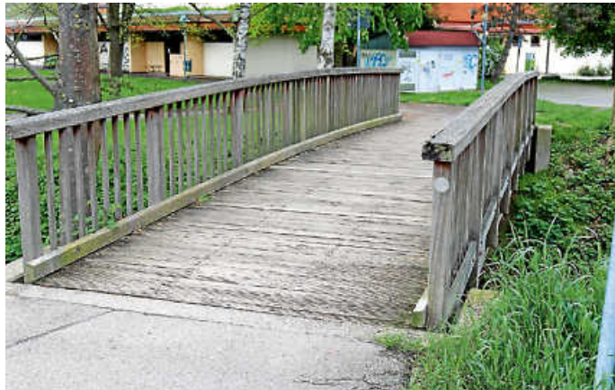
Der Flößersteg wird erneuert.
