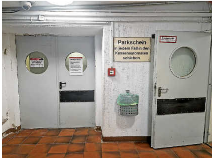
Der Zugang zum Aufzug steht nicht mehr zur Verfügung.
