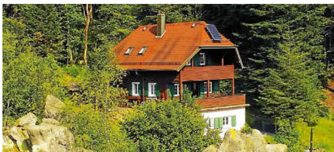
Das Orgelfelsenhaus kann am 4. August besichtigt werden. Foto: Schwarzwaldverein Gaggenau
