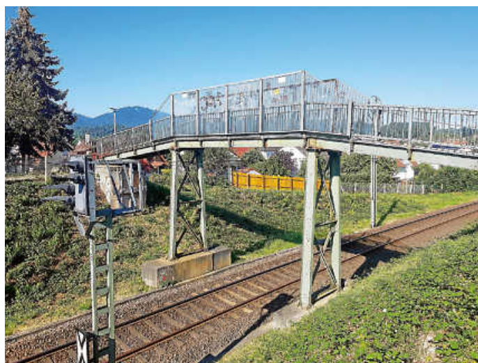
Die alte Fußgängerbrücke muss abgebaut werden.
